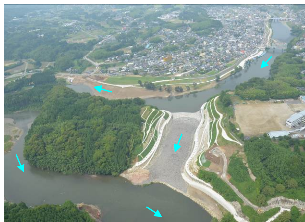
写真-18 推込分水路より整備区間全景
