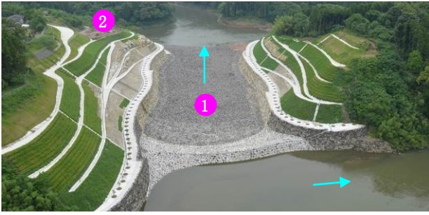
写真-22 推込分水路
