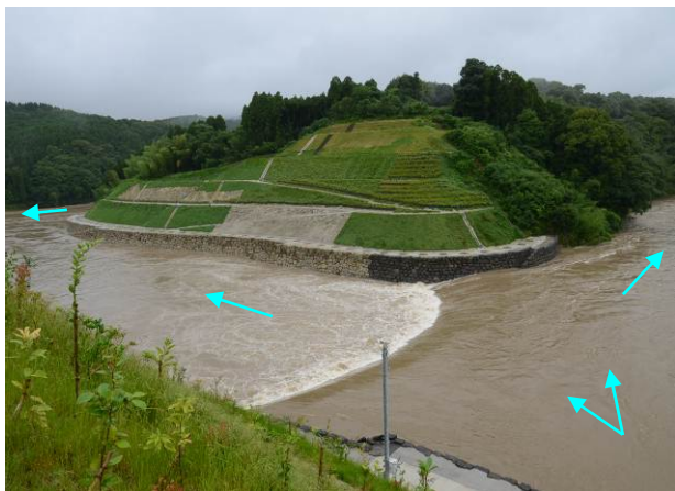
写真-17 推込分水路 洪水分流状況
