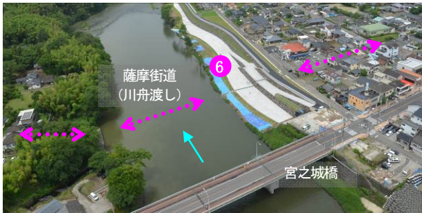
写真-24 宮之城橋周辺
