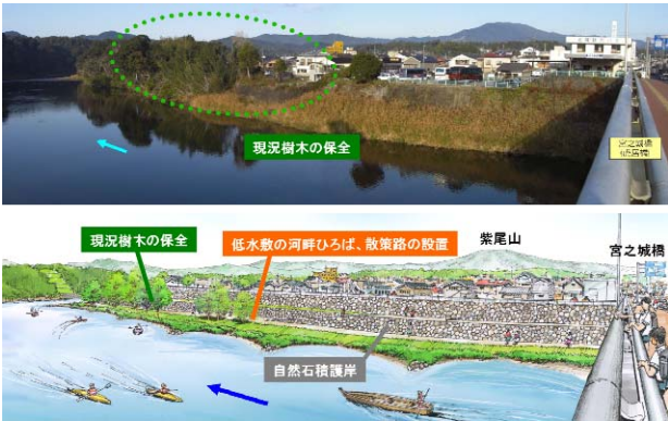
図-7 宮之城橋より下流右岸を望む
