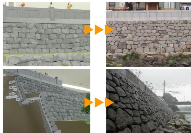
写真-19 石積み護岸工の比較 (左：模型, 右：現場)
