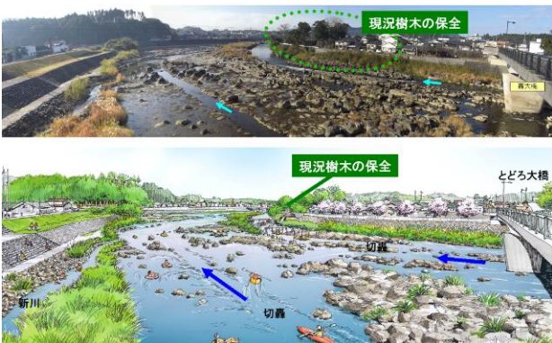
図-10 川原地区より轟大橋下流右岸を望む
