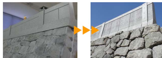
写真-20 パラペットの比較 (左：模型, 右：現場)
