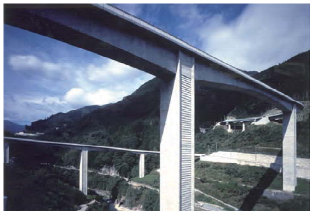
写真-1 雷電廿六木橋竣工時(1998年)
