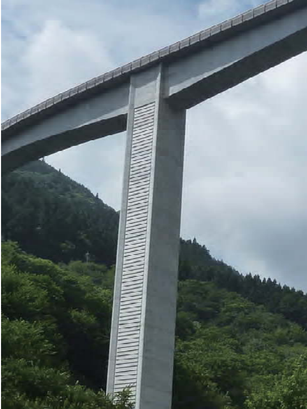
写真-12 橋脚の表面性状（東向きの壁高欄と橋脚の汚れ性状を対比して見ることができる）
