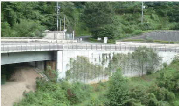
写真-13 橋台、補強土壁の表面性状
