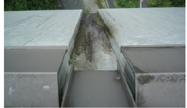
写真-6 縦溝の水仕舞い(菌類の付着が確認できる)
