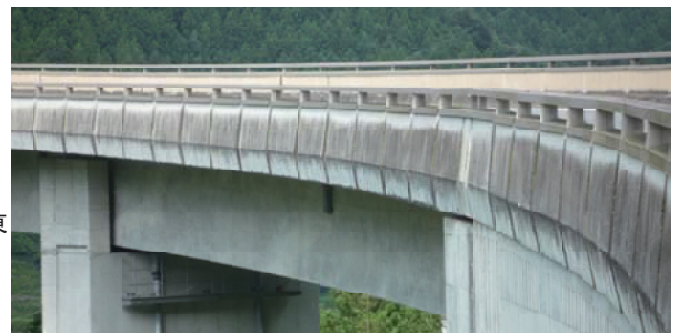
写真-10 大滝大橋P1橋脚からA1橋台（西から北西向き）
