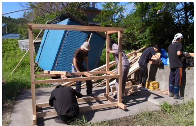
図-2 組み上げ作業の様子
