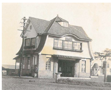
図-5 建設当初の旧田園調布駅舎
