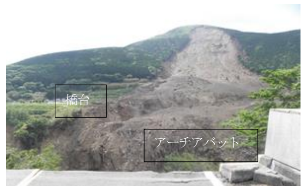
図-7 対岸からのA2橋台状況(2016年5月20日) 3)
