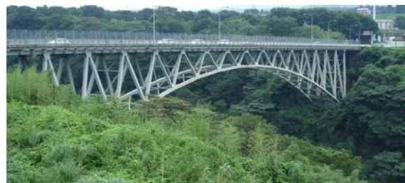
図-1 損傷前の阿蘇大橋 1)
