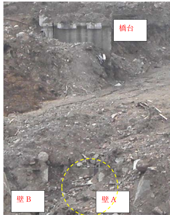
図-10 橋台付近の地形状況 (2016年5月20日)
