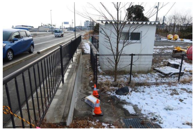
図-6 01（京都大学防災研究所）の地震計設置状況
