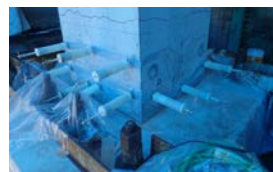
写真-1 ひび割れ注入状況
