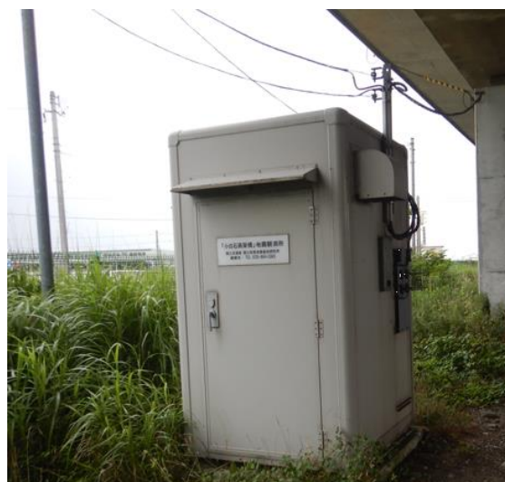
図-6 既存局舎の例
