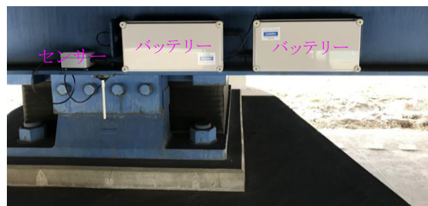
図-4 鋼製桁部設置例
