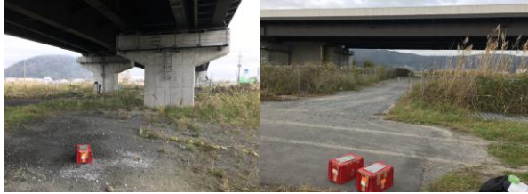
図-7 微動観測状況（左：橋の直下，右：地盤）
