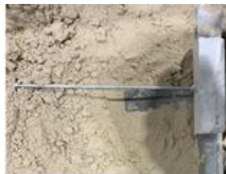
図-24 アンカー補強
