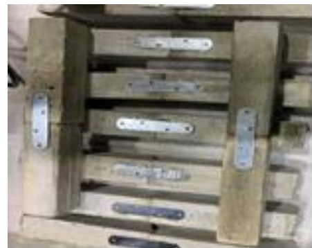
図-23 ダブルブラフ擁壁の補強
