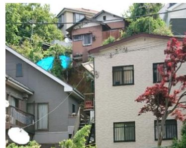
図-3 横浜市中区打越の住宅地の崩壊
