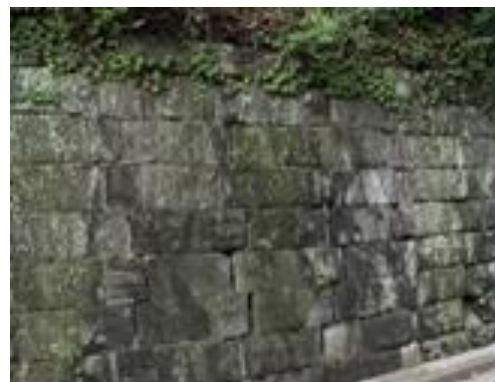
図-22 ダブルブラフ擁壁
