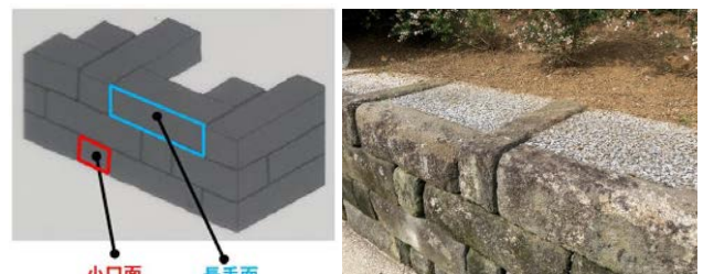
図-1 ブラフ擁壁の構造模式図
