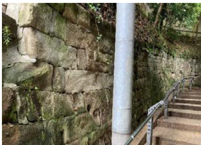
図-8 変状後の修復の様子
