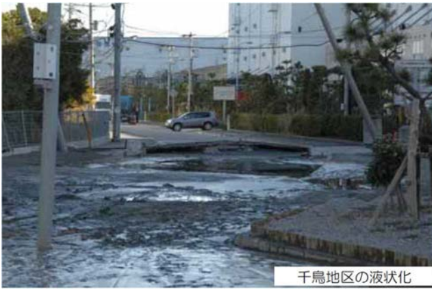
図-1 浦安市における液状化による道路被害 2)
