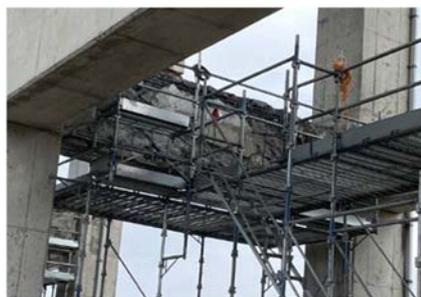
写真-1 2層式RCラーメン高架橋の中層梁のせん断損傷<sup>1)</sup>
