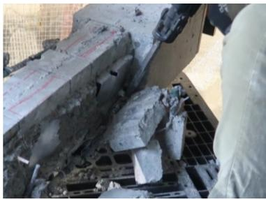
図-14 鋼板位置ではのはつり作業の様子
