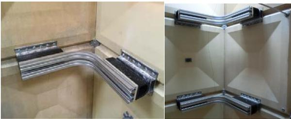
写真-3 制振装置取り付け時
