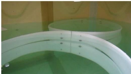
写真-4 8の字型浮体式制振装置の設置状況
