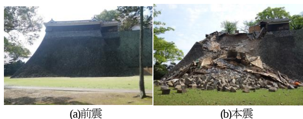
写真-1 熊本地震による重要文化財北十八間櫓石垣の崩壊
