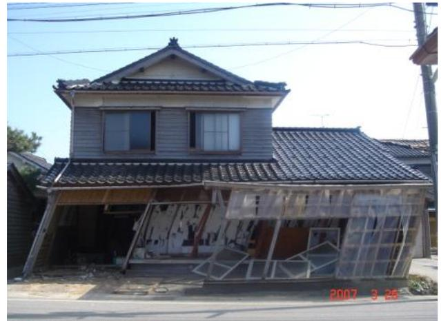
図-3 1階部分が大きくせん断変形(約1/4)した2階建て木造家屋の倒壊の事例
