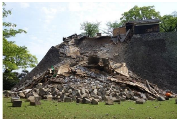
写真-1 熊本城重要文化財「北十八間櫓」石垣の崩壊
