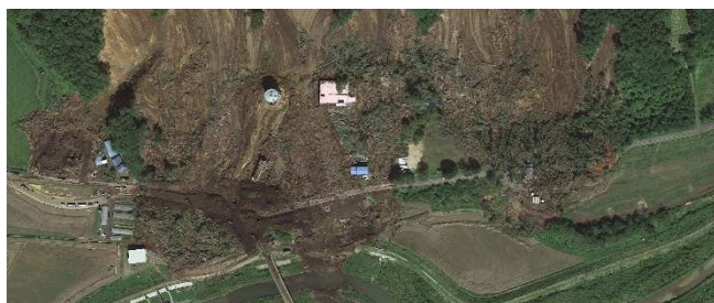
図-2 空中写真より同定した被害地点の一例(斜面崩壊)
