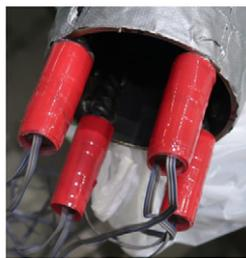
図-4 せん断キーへのアンボンド処理
