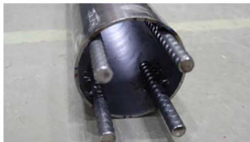
図-2 鋼管下端に接合するずれ止めせん断キ
