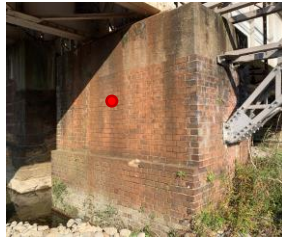
図-12 対象橋脚（赤丸は加速度センサ設置箇所）
