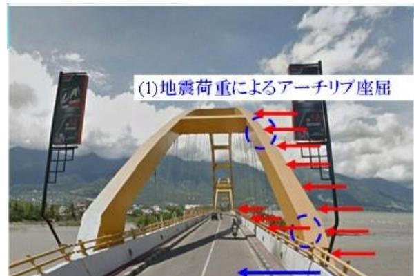
図-14 地震荷重の作用状況
