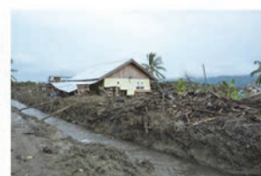
図-16 下流側の家屋被害
