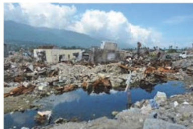
図-6 下流側の家屋被害
