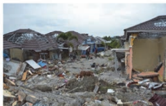
図-12 下流側の家屋被害
