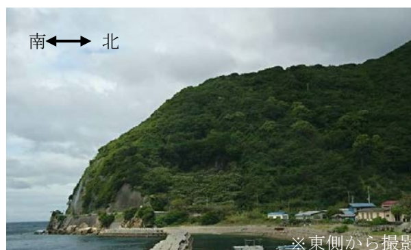
図-2 調査対象斜面の写真
