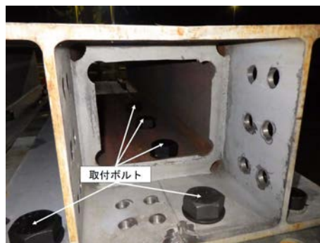
写真5 取付ボルト部
