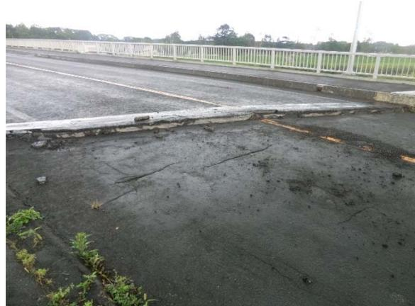
図-6 取付部の段差 (A2側) (厚真新橋)
