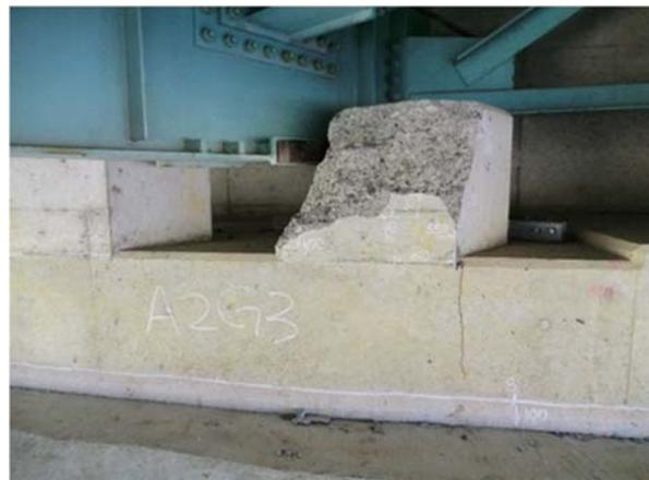
図-21 コンクリートブロック損傷 (A2) (宇隆橋)
