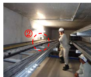
②ダクト部 (遠景)
