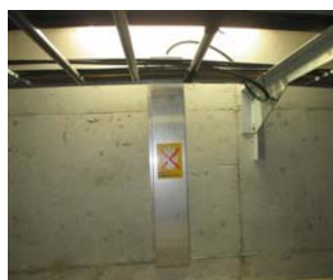
②ダクト部 (近景)
