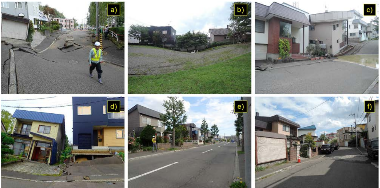
図-4 図-3に示した地点の被災状況
