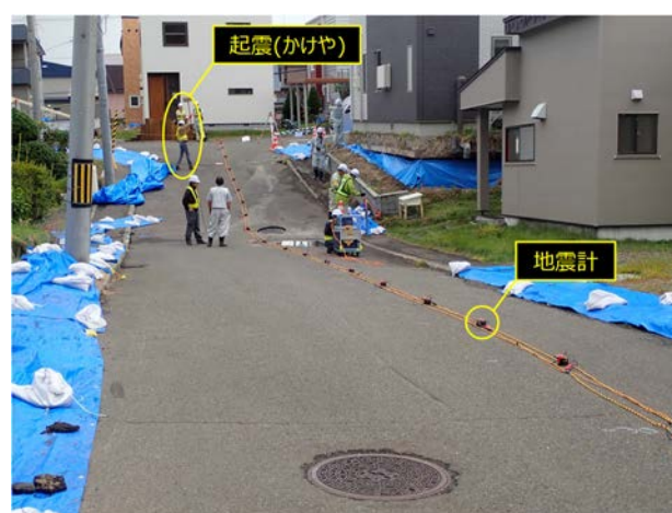
図-2 表面波探査の実施状況の例
