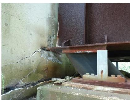
写真-2 A1 橋台部と桁端部の衝突
