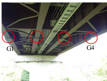
写真-1 主桁下フランジの座屈
