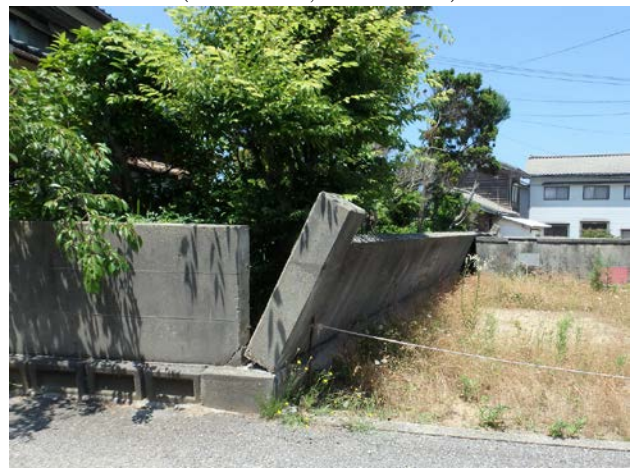
写真-8 府屋地域における補強されていないブロック塀の傾斜 (N38.514325, E139.53343)
