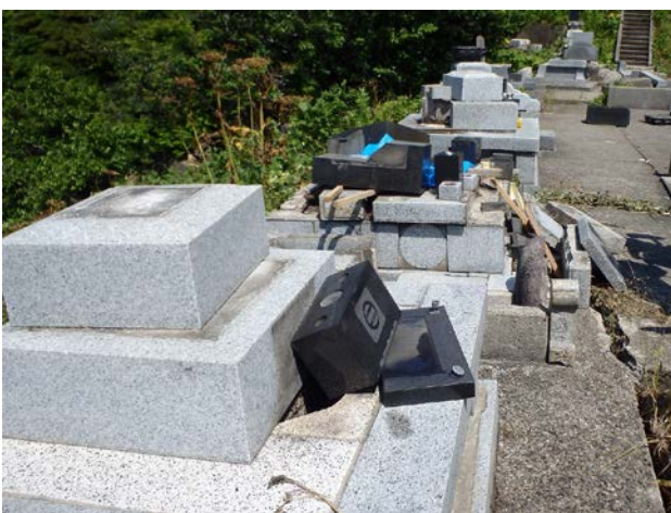
写真-11 小岩川の墓地での墓石の落下 (N38.589553, E139.565355)
