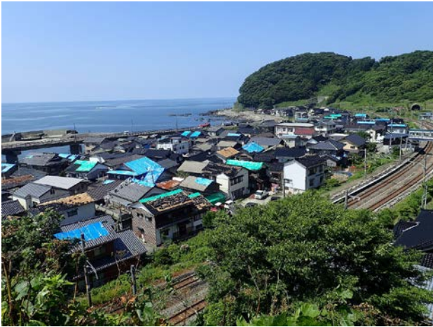
写真-10 小岩川の瓦屋根被害 (N38.589305, E139.56581)
