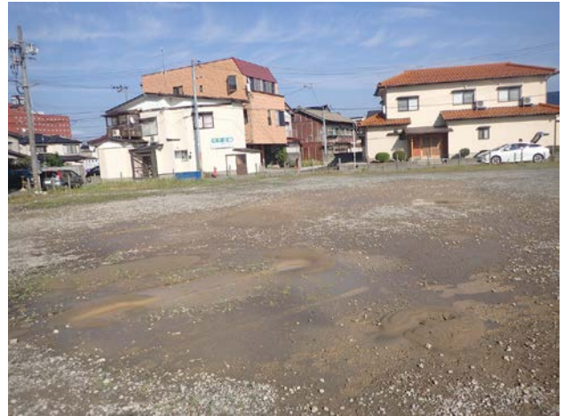
写真-13 鶴岡駅付近の駐車場で発生した液状化 (N38.738543, E139.836162)
