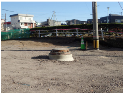
写真-1 札幌市清田区の液状化被害(1)
