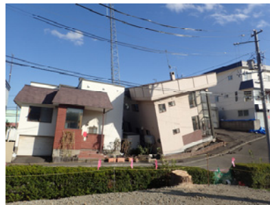
写真-2 札幌市清田区の液状化被害(2)
