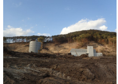
写真-6 勇払郡厚真町の斜面崩壊被害(2)
