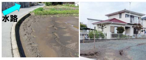
図-3 液状化被害状況(左：農地における噴砂，地割れの状況，右：水路付近の民家の状況)
