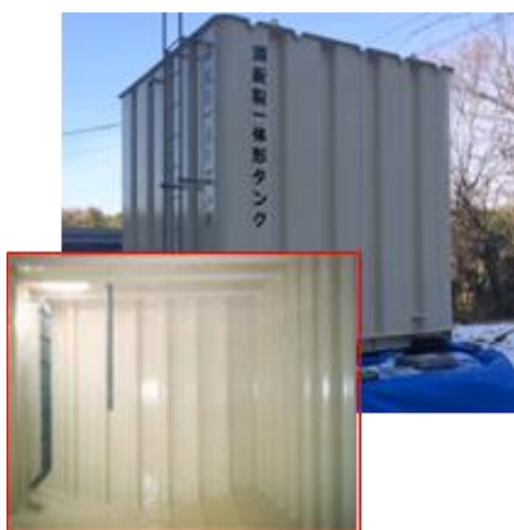
写真-2 鋼板タンク
