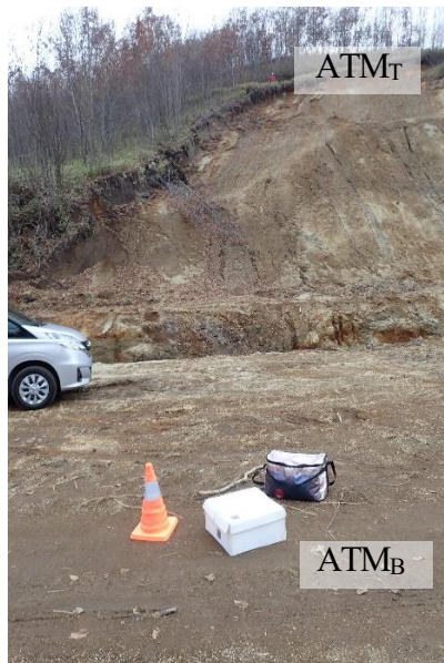
付録写真-1 斜面崩壊箇所の観測地点
