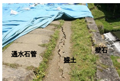
(a) 壁石のはらみ出しと盛土の亀裂 2)
