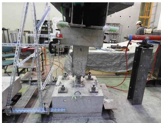
写真-5 塑性ヒンジ損傷部撤去後の状況
