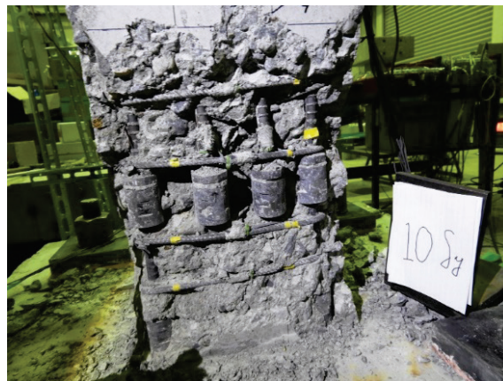
写真-3 新型橋脚基部の終局状況
