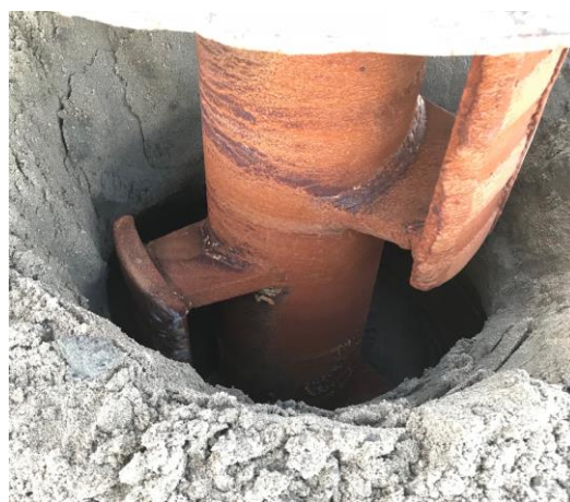
写真-2 オーガースクリューによる削孔
