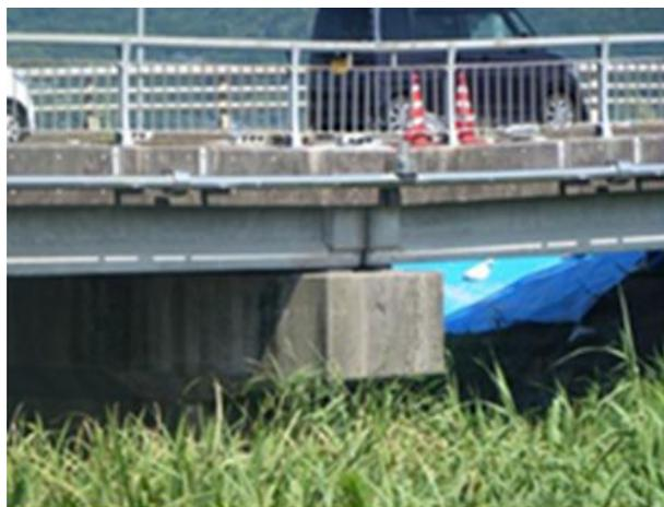
写真-1 中間橋脚の沈下現象
