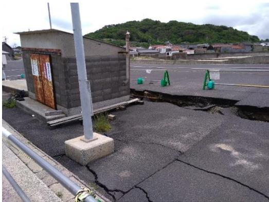
写真-1-(c) 波根東港の液状化(波根地区)
