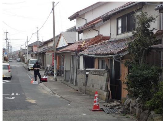
写真-1-(d) 建物被害・地盤変動(久手地区)
