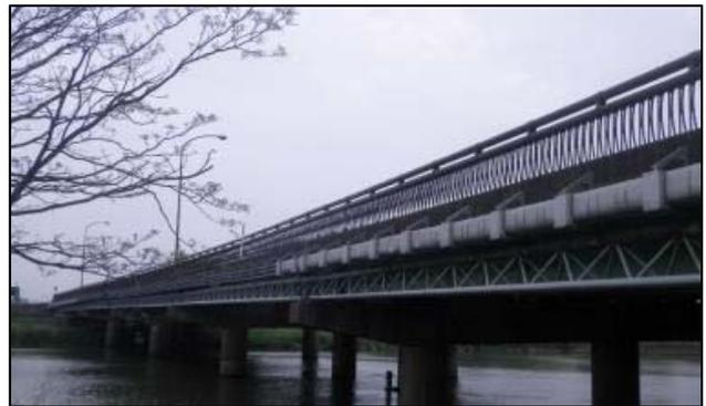
図-2 専用橋の例（トラス）
