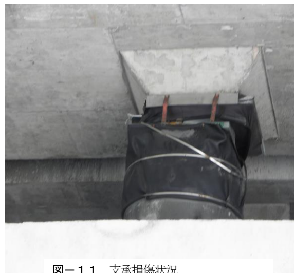
図－１１ 支承損傷状況
