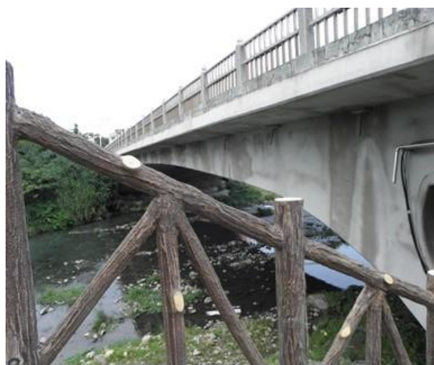
図－18 中正橋桁形状
