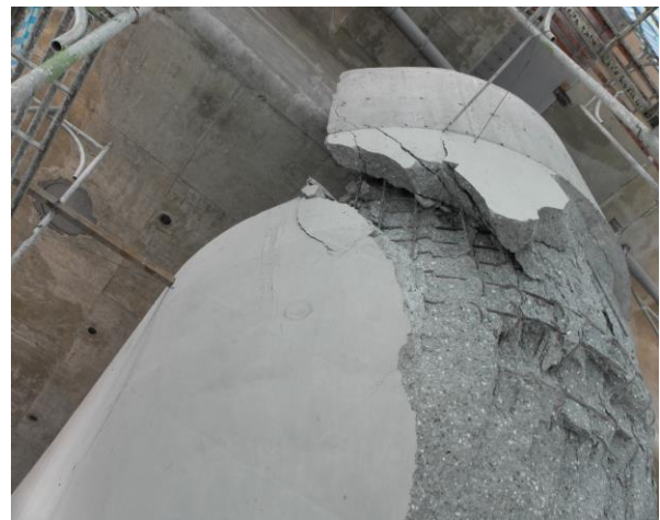
図－9 七星澤大橋 P1 橋脚損傷状況
