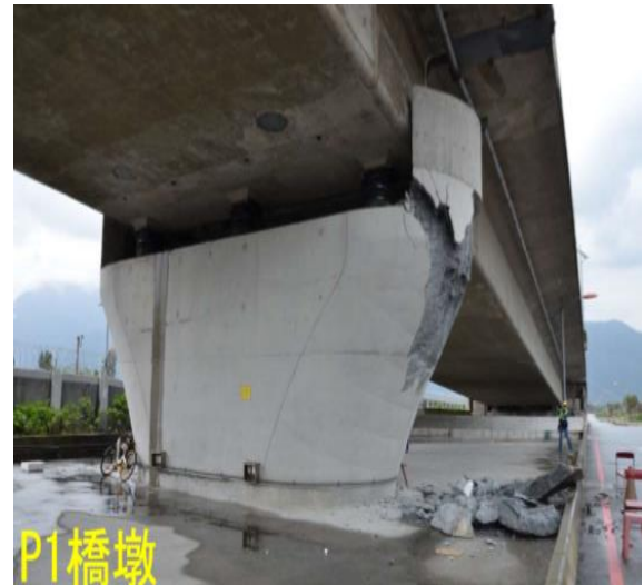
図－8 七星澤大橋 P1 橋脚(文献 7)
