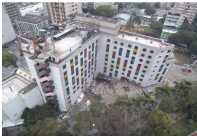
図－2 Marshal ホテル損傷状況（文献1）
