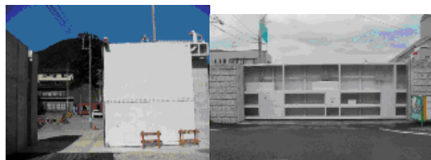
図-7 施設出入用の防水門扉（陸閘）
