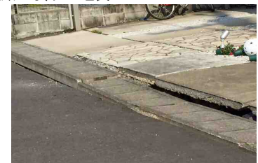
(b)側溝の開き・沈下
