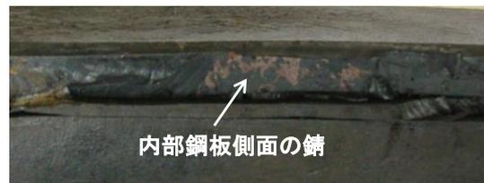
図-4 内部鋼板側面の錆
