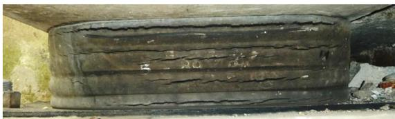
写真-1 検討対象支承に発生していたき裂
