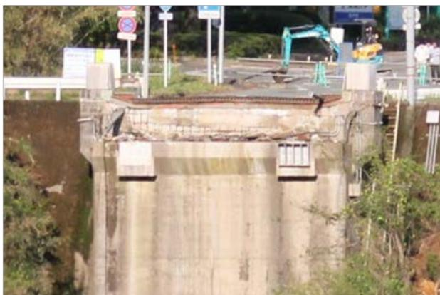
写真-1 桁が衝突したと思われるAIアバットの損傷
