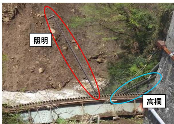
写真-2 2016年4月17日に撮影した崩落した床版
