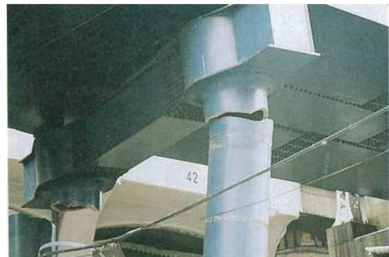
写真-1 神戸高速鉄道の三宮駅付近の高架橋 鑄鉄製橋脚の被害様子
