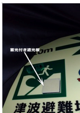
写真6 遮光板設置状況
