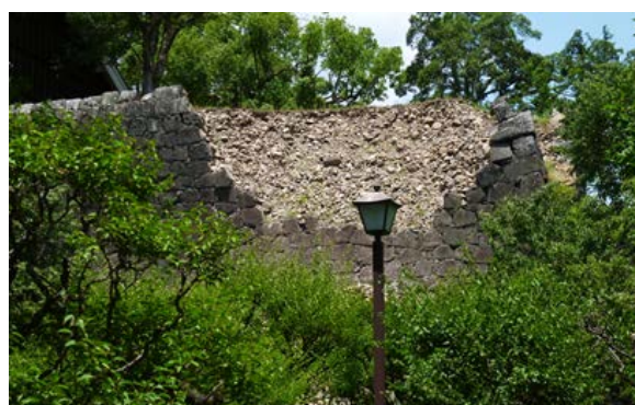
写真-1 数奇屋丸二階御広間東側の石垣崩落
