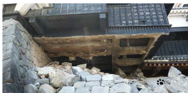
写真-4 天守の基礎部分の RC 梁
