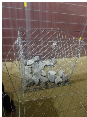
写真-3 蛇籠組立状況
