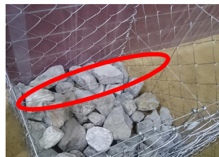
(b) 蛇籠内に設置した張り線
