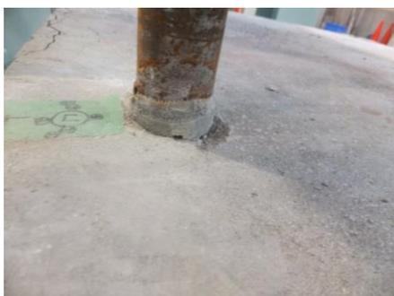
図-35 鋼棒付近の圧縮応力による損傷状況
