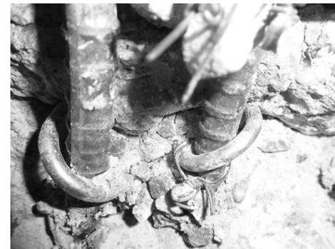
図-15 フック部が開かず軸方向鉄筋の座屈に抵抗している様子
